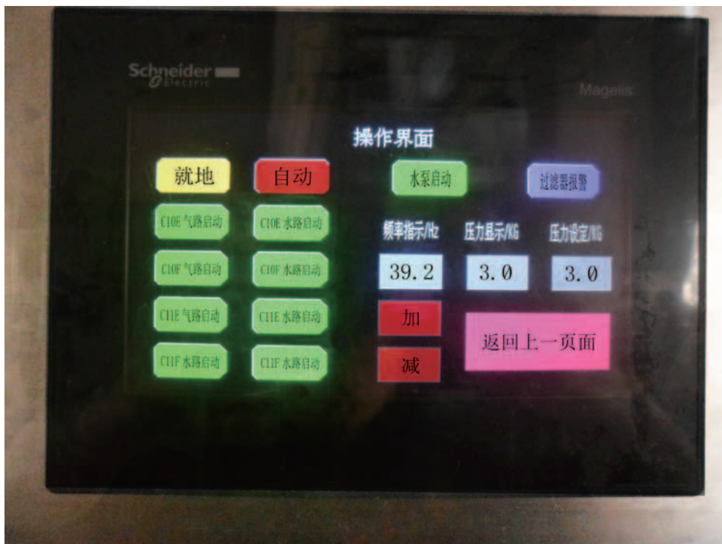
除尘装置触摸屏控制柜
